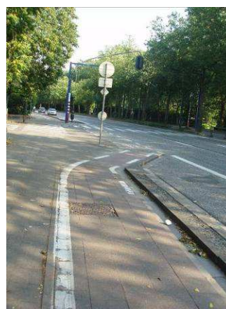
Direction Van Praet, piste cyclable qui revient sur la chaussée au carrefour
