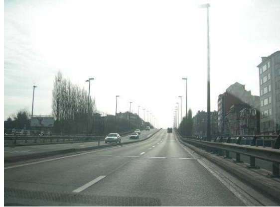
Bvd Reyers - viaduc
