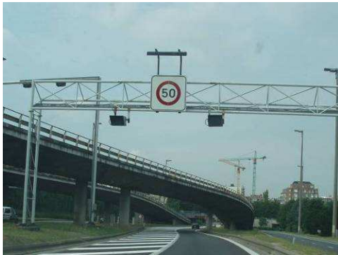
Tunnels Reyers-Centre - portique d'entrée en agglomération
