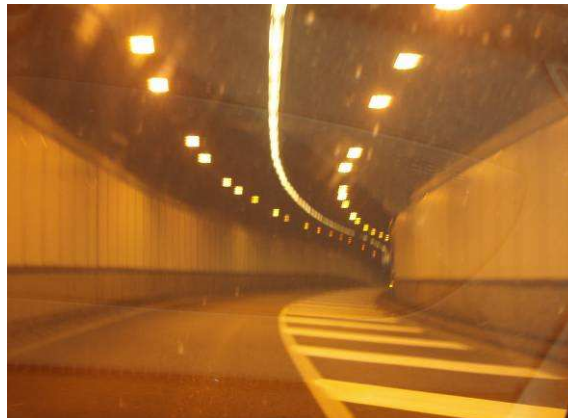
Figure 37 : tunnel Reyers-Centre (une seule bande de circulation par tube)
