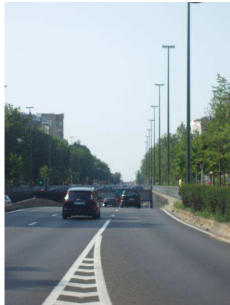
Entrée tunnel Georges Henri
